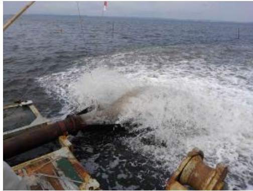
左：圧送ポンプによる砕石散布
