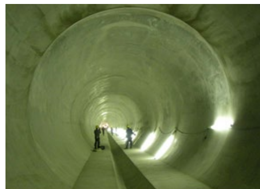
合流式下水道の改善 雨水貯留施設の整備
