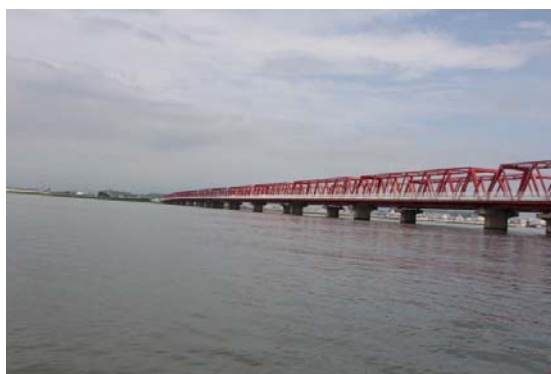
調査場所は国道 23 号線伊勢大橋上流約 500m の地点
