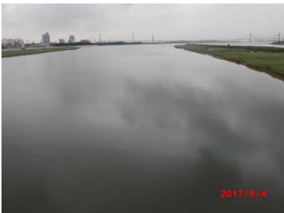
橋の中央部より
