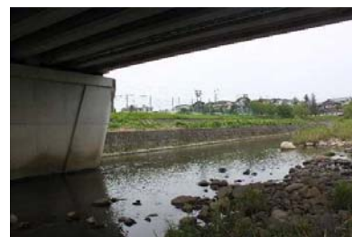
明德橋下流方面
