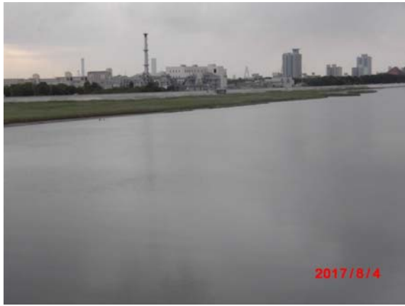
橋の中央部より左岸側（宝神水処理センター）
