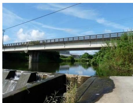
堰堤・魚道・橋脚はコンクリート
