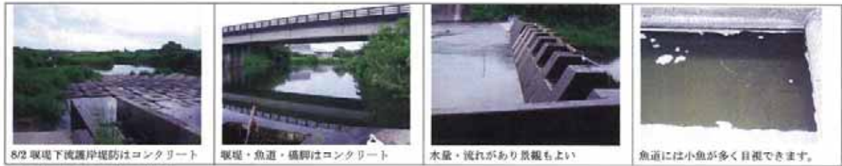
8/2 取場下流護岸堤防はコンクリート
