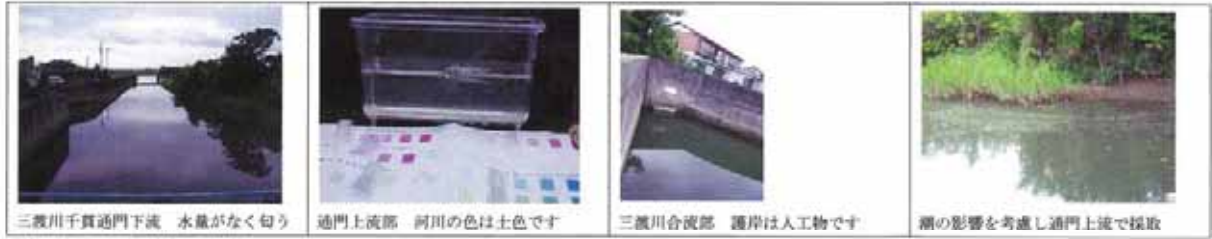
三渡川千貫通門下流 水量がなく匂う
