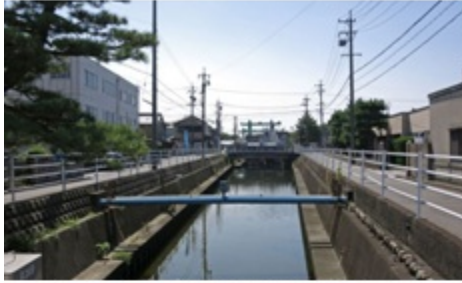
田邊1号線から豊栄橋(十四川河口方向)を望む
