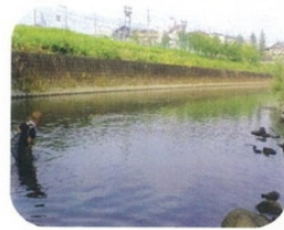
明德橋下流方面
