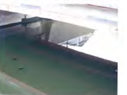
豊栄橋真下の状態
