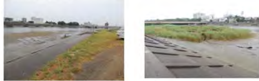
調査地点 豊川右岸 下地 調査地点周辺の状況写真
