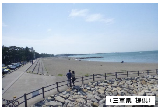
〈緩傾斜護岸の整備〉 (三重県宇治山田港海岸)
