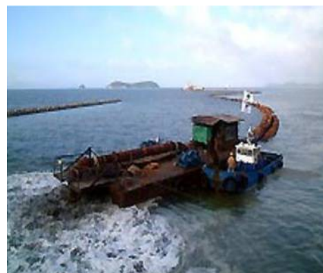
写真：覆砂実施状況
