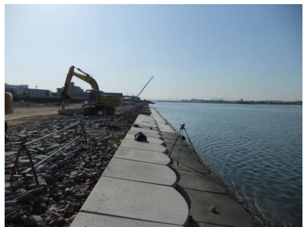
写真：階段護岸整備状況
