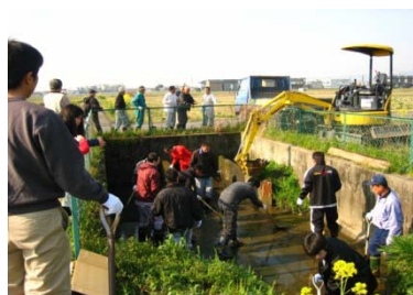
【水路の泥上げの様子】
