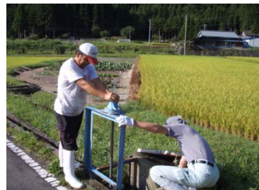
【農業用水路の機能点検の様子】
