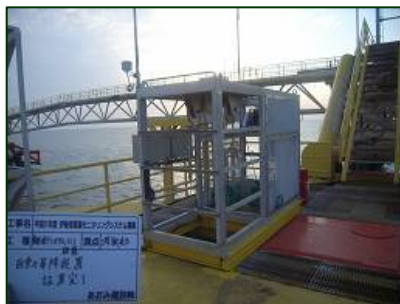
写真-1: 伊勢湾シーバース （自動昇降式装置）
