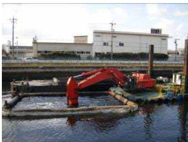
写真：浚渫の様子
