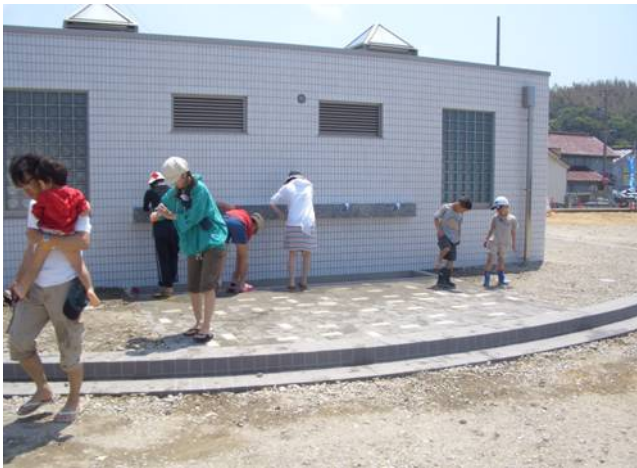
トイレ整備状況
