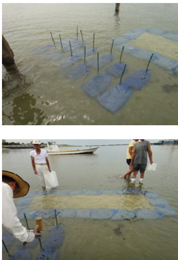
図1 カキ殻固形物の漁場への設置
