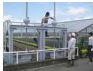
農業用施設の機能点検の様子
