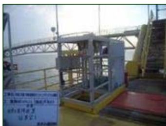
写真-1: 伊勢湾シーバース （自動昇降式装置）
