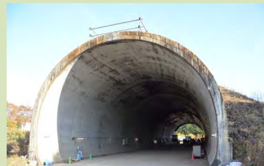
模擬トンネル
