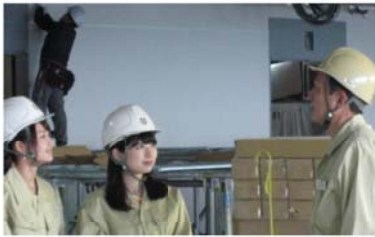
(建設現場訪問)
