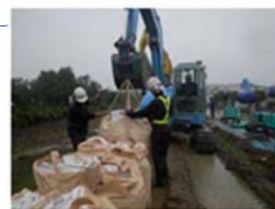
大型土のう設置作業
