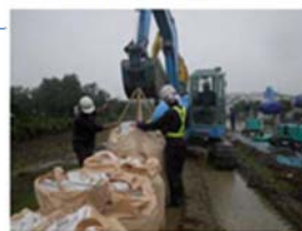
大型土のう設置作業
