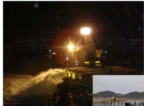
夜を徹しての排水作業(翌朝より自衛隊による捜索が開始される)
