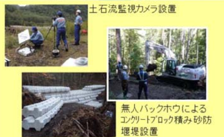
土石流監視カメラ設置
