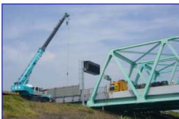
高速道路より木曾川右岸堤防へ大型土のうを搬入
