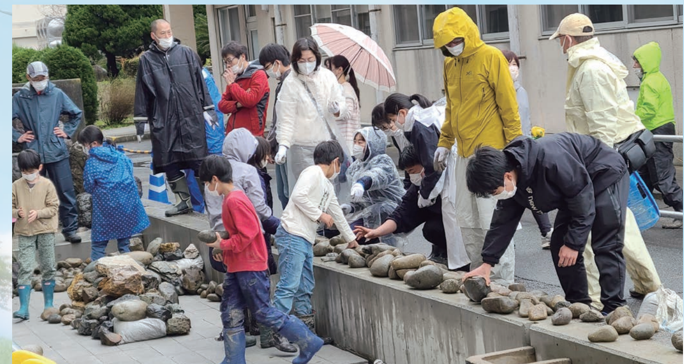
R4.12月 木曽川の環境に詳しい(株)建設環境研究所の方々の指導の下、越小学校の児童の皆さんと一緒に池にU字溝、土嚢を入れて、池底の基礎を作りました。
