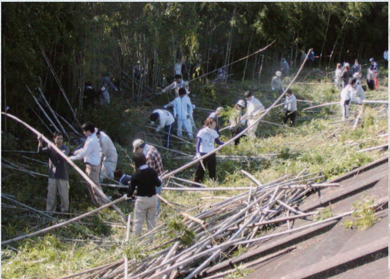
竹藪伐開 岐阜市職員研修で体験作業
