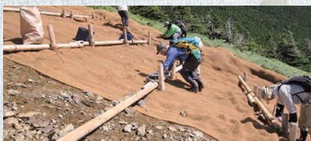
土砂流出防止作業
