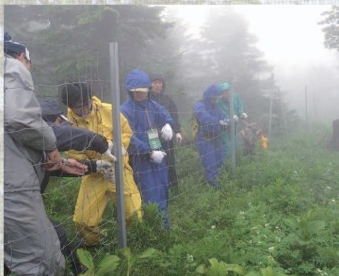
防鹿柵の補修作業
