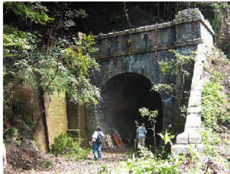
姿を現した6号トンネル
