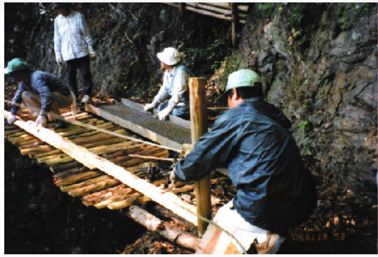
始神峠江戸橋整備作業
