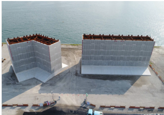
《製作途中の耐震強化岸壁の一部》
