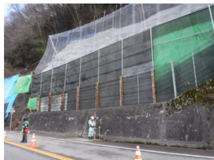
施工中の状況
