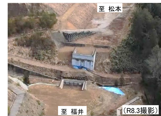
写真②: 稲部谷橋付近の状況
