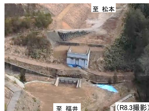
いなぶだに 写真②：稲部谷橋付近の状況
