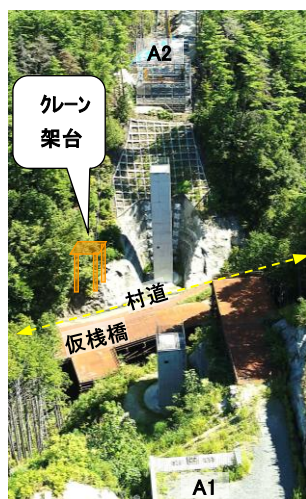
<2号橋周辺現況>
