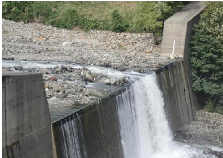
対策例 耐摩耗性と耐衝撃性に優れたゴム・鋼板製の コンクリート保護工の採用
