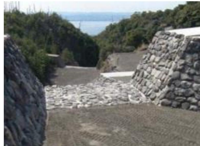
対策例 堰堤摩耗損傷対策のための転石コンクリート 本省HPより
