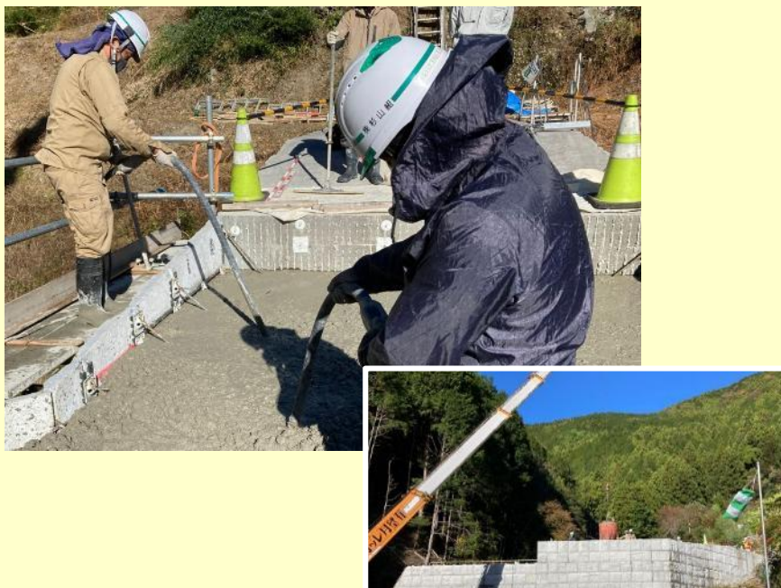
上有東木砂防堰堤における残存型枠の使用事例
