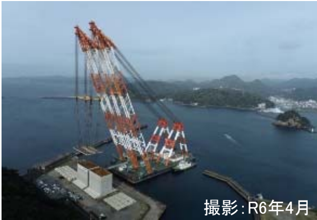
ケーソン吊上げ状況（据付準備）
