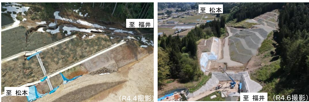
写真②: 坊方地区の切土法面・押え盛土状況
