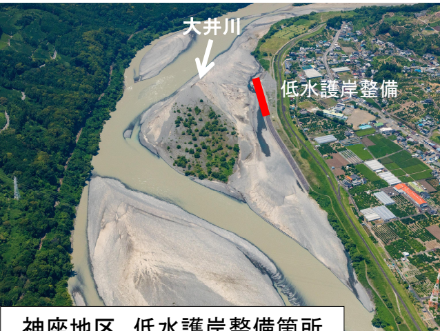
神座地区 低水護岸整備箇所
