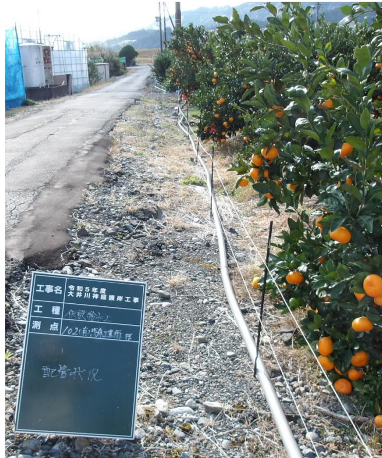
仮設上水道設置
