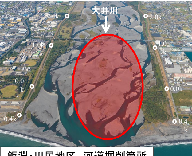
飯淵・川尻地区 河道掘削箇所
