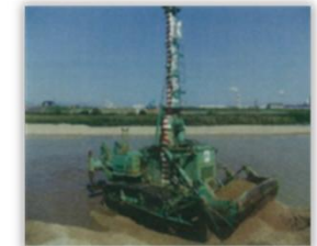
河道掘削土砂の処分が必要
