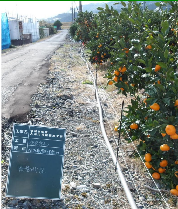
仮設上水道設置
