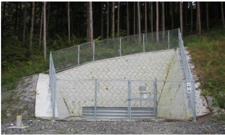
集水井工(R6.3完成)
