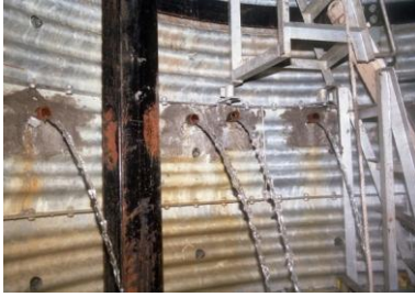
地下水の排除状況
