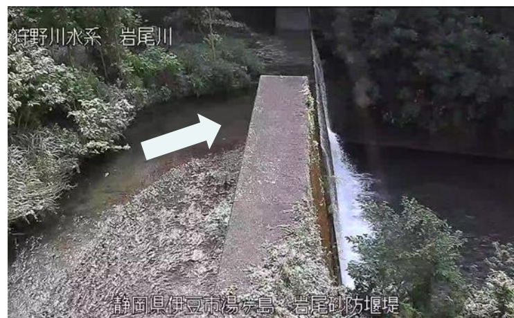
CCTVカメラ画像(岩尾砂防堰堤) いわび
