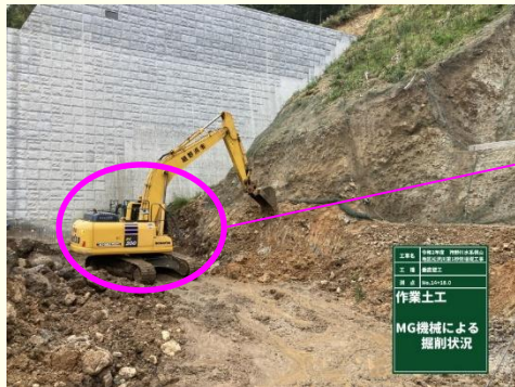
※松沢川第1砂防堰堤 施工時の事例
