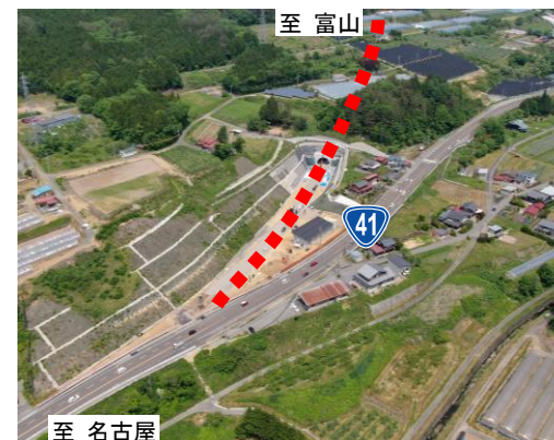
写真: 宮峠トンネル(久々野町側)の状況
