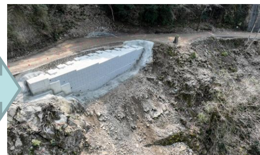
工事用道路工事（拡幅）
