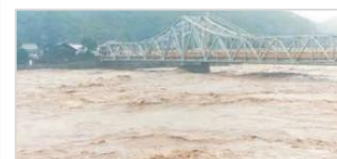
S57.8洪水: 浜松市鹿島橋付近
