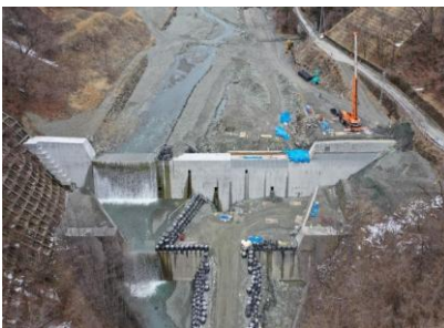
土砂流出対策 (砂防堰堤の設置)
