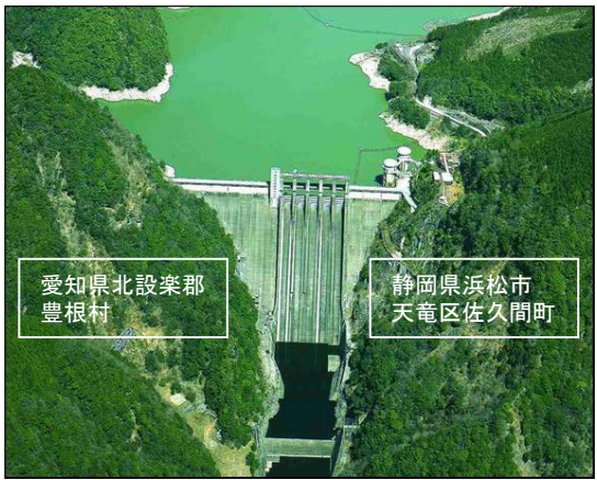
佐久間ダム(電源開発(株)S31完成)
