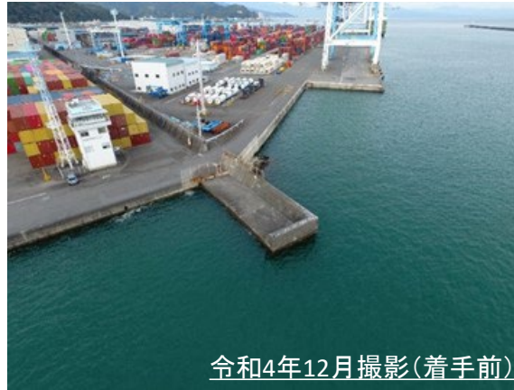
防波堤の撤去(着手前後)
