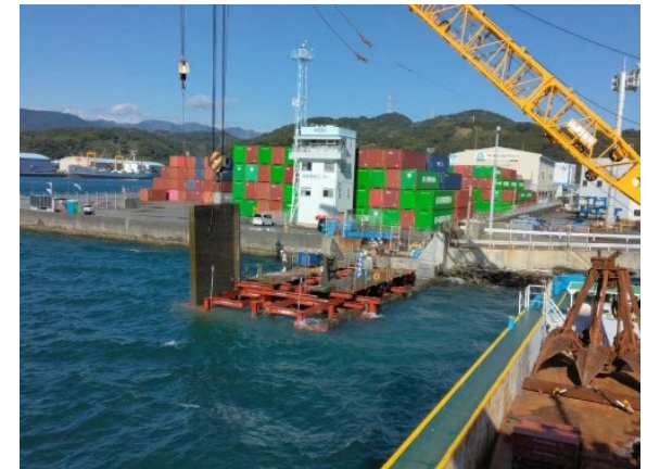
防波堤ケーソン隔壁の撤去
