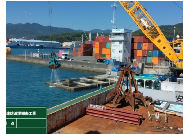
防波堤ケーソン中詰砂の撤去
