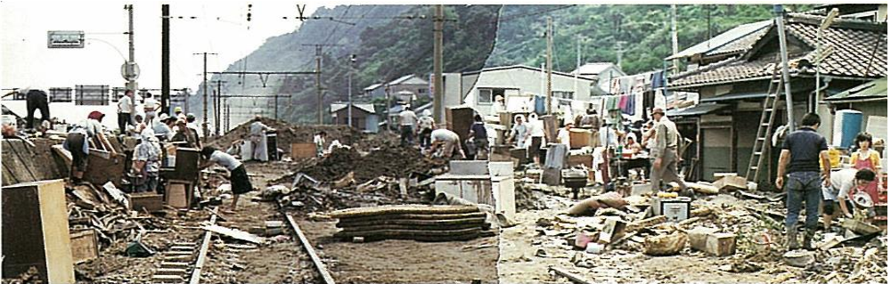
図2-1-1 由比駅付近での被災状況 (S49.7)
