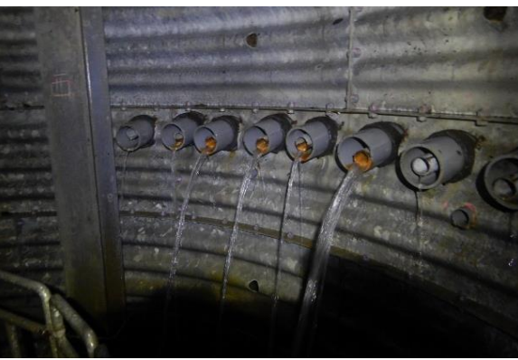
図3-1-2 集水井と排水トンネルの排水状況 (山中ブロック)
