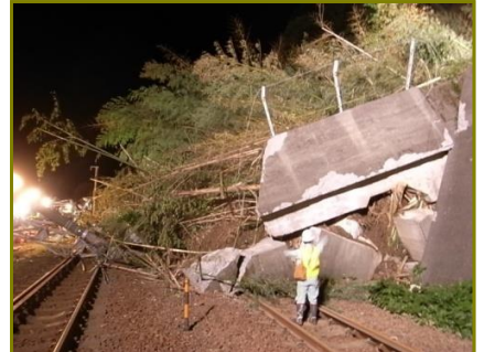
図2-1-2 興津東町での表層崩壊状況 (H26.10)
