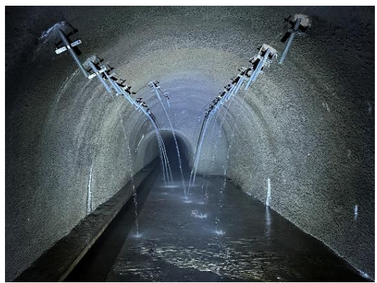
図3-1-2 集水井と排水トンネルの排水状況 (山中ブロック)
