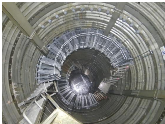
図3-1-1 集水井工施設と点検状況 (山中ブロック)
