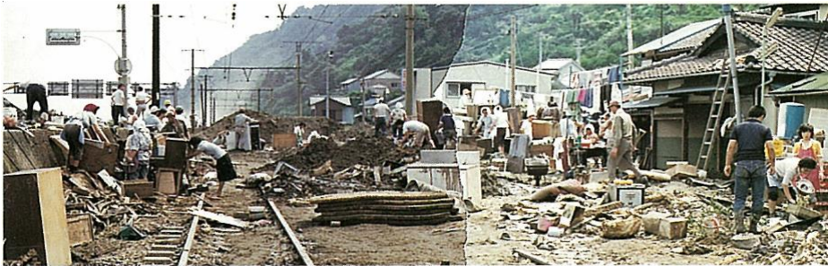
図2-1-1 由比駅付近での被災状況（S49. 7）
