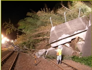
図2-1-2 興津東町での表層崩壊状況（H26. 10）
