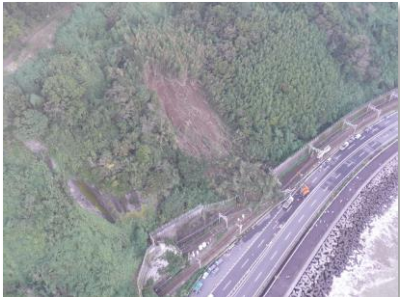
図2-1-2 興津東町での表層崩壊状況（H26. 10）
