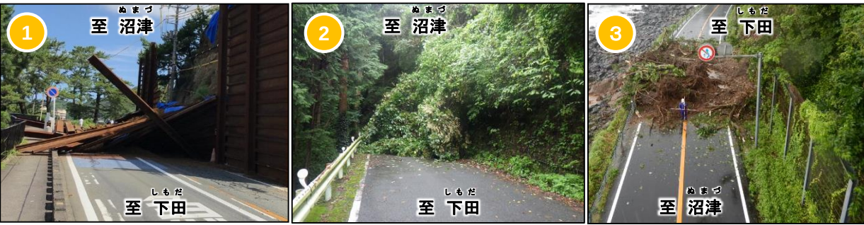
【国道136号 法面崩壊】 にし 伊豆町仁科 (R2.7 西伊豆町仁科) 【国道414号 倒木】 かわ 河津町逆川 (R6.9 河津町逆川) 【国道135号 法面崩壊】 い 伊東市赤沢 (R2.7 伊東市赤沢)
