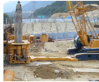
杭施工状況写真（イメージ）
