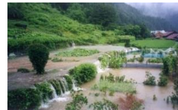
氾濫水が溢れ出る様子(揖斐川町乙原) おとほら
