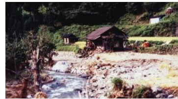
たかち 高知川沿いの被災状況
