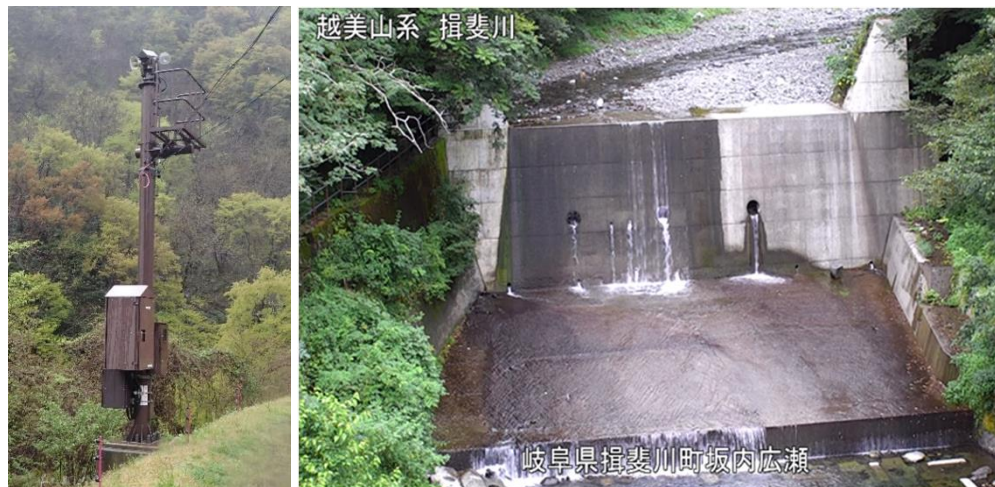
主要溪流への監視カメラ設置
