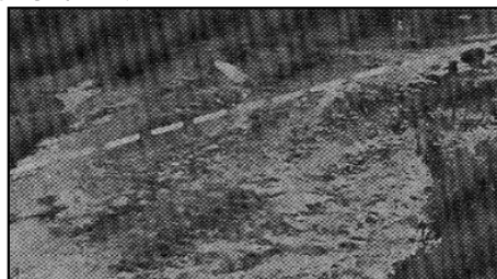
川上地区の被災状況
