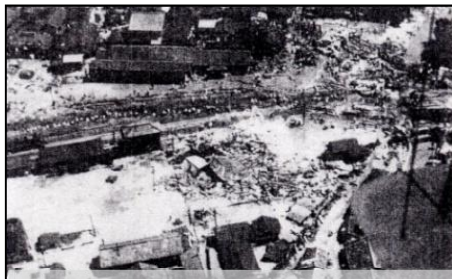
中津川市内の被災状況
