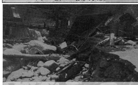
川上地区の被災状況*1)
