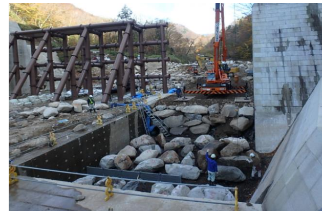
現地発生材(巨石)を利用した整備事例 (中津川第11砂防堰堤)
