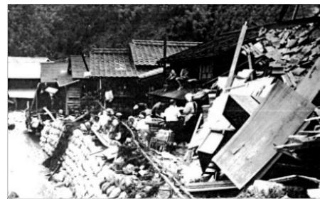
土石流に破壊された人家
