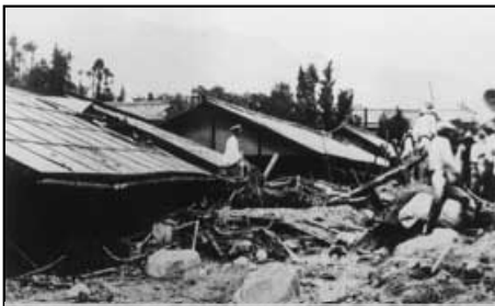
中津川市内の被災状況
