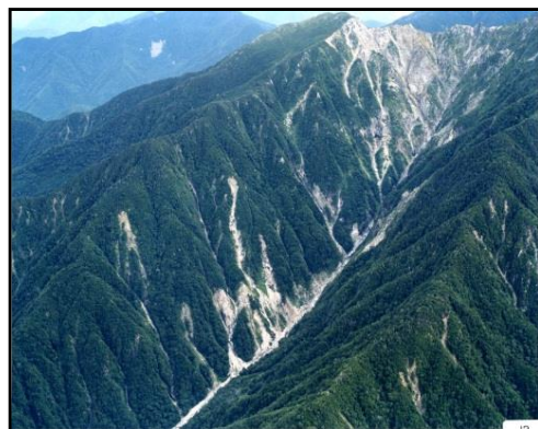
滑川上流の崩壊状況
