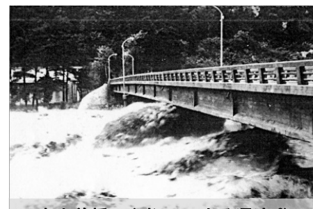
南木曾橋の主桁にせまる濁流*2)
