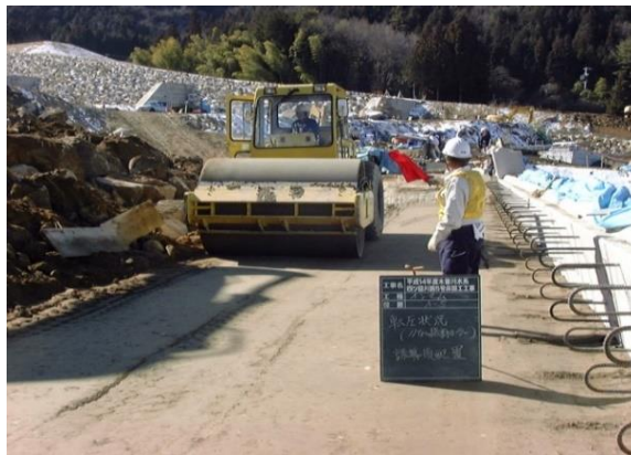
砂防ソイルセメントを活用した整備事例 (北股沢床固工群の事例)
