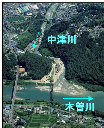
中津川からの土砂流出状況
