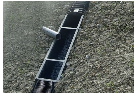
地下水の排除状況（表面排水路）
