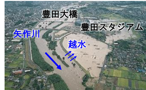
豊田市街地付近の越水氾濫状況
