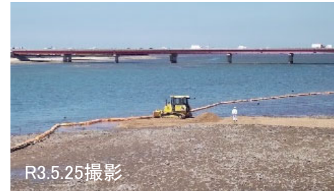
掘削土の干潟再生への利用
