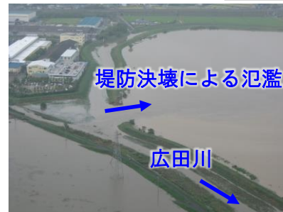
広田川の堤防決壊状況(幸田町菱池)
