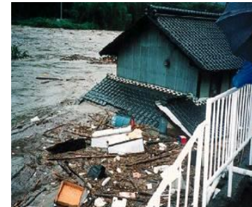
浸水した家屋(豊田市藤沢町)
