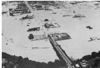
豊田市街地南部地区の被害状況 出典:「川と人 矢作川」
