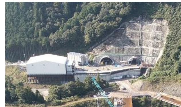
養老トンネル岐阜側坑口
