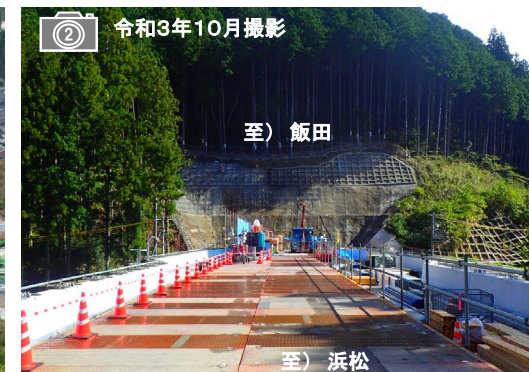
■トンネル工事(東栄町工区)進捗状況
