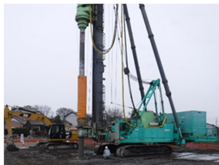
支持力対策の施工状況
