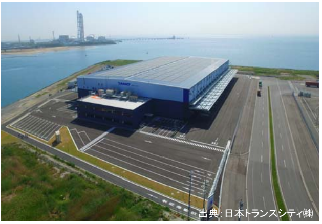
写真:霞北埠頭流通センター
