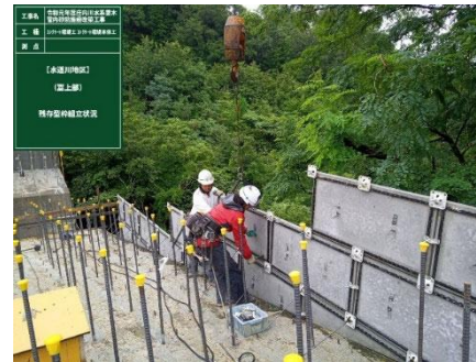
残存型枠を利用した整備
