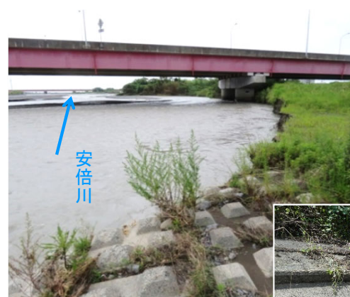
令和2年7月豪雨 ▶ 牧ヶ谷地先護岸損傷状況 (藁科川右岸0.5k)
