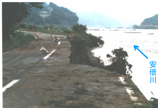
▲平成3年9月洪水 俵沢地区(21.5k付近左岸)被災状況 8-7
