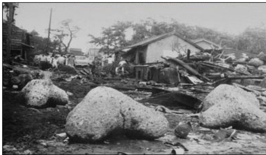
昭和41年 台風26号 高波、浸水により被災した家屋 よしわら いまいちさき (吉原工区今井地先)
