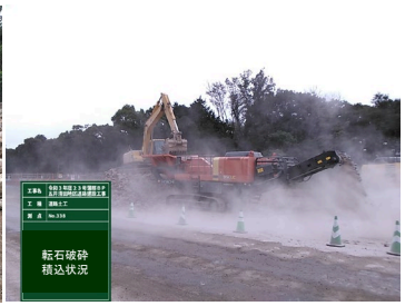
自走式破碎機にて二次破碎 ※盛土に使用可能な大きさに破碎
