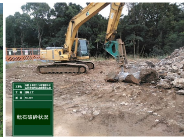
ブレイカーにて一次破碎 ※破碎機に投入可能な大きさまで小割
