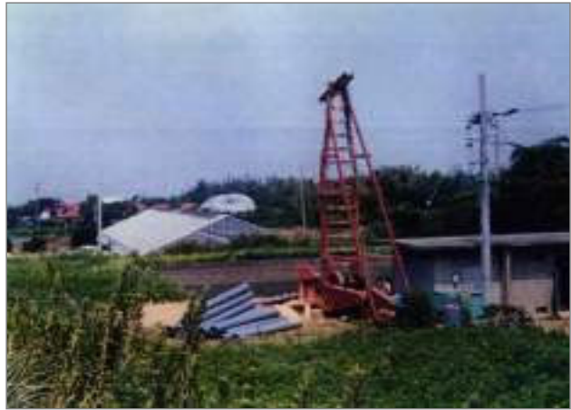
応急井戸掘りの様子 (平成6年)
